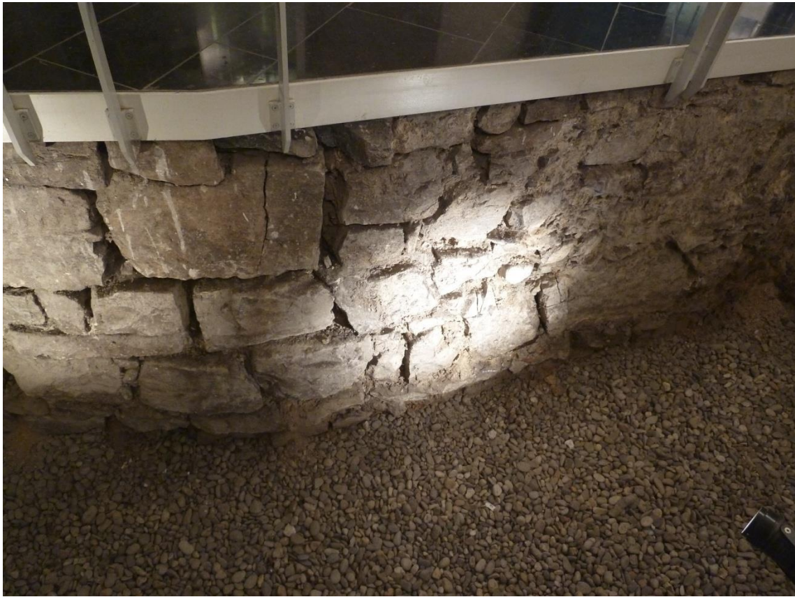
Base d'une tour de la 2 e enceinte.
